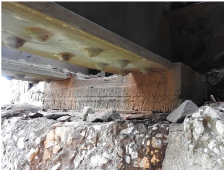
Obr. 1 Konstrukce K 01 – pravé ložisko na O01 - uvolněné ložisko a vydrolené obetonování, koroze ložisek. (listopad 2018)
