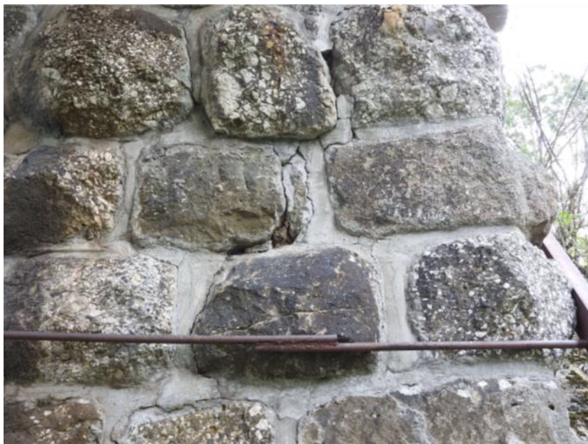
Obr. 3 Opěra O02 - vpravo – trhlina, degradované spárování. (listopad 2018)
