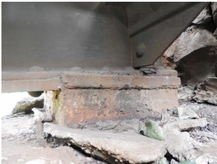
Obr. 2 Konstrukce K 01 – levé ložisko na O02 - porušené zalití, zatlačení. (listopad 2018)
